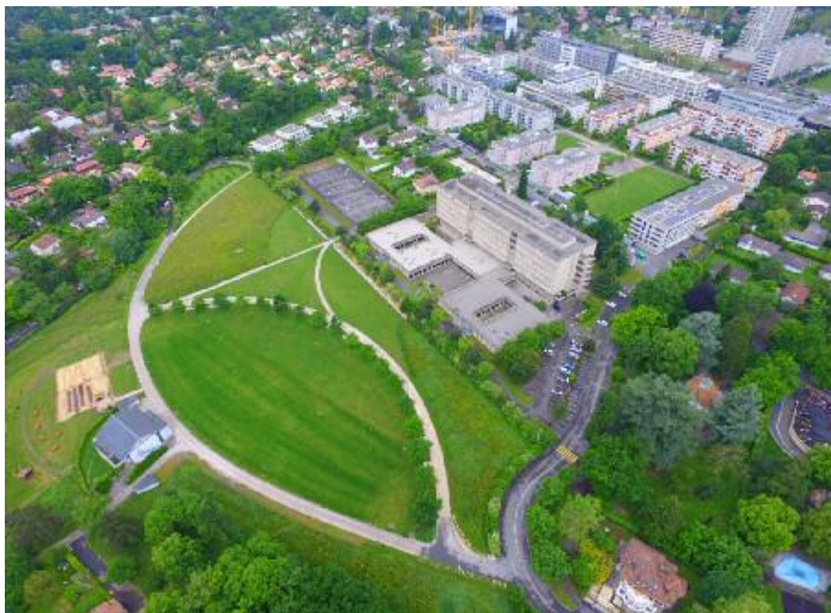
Vue aérienne du Parc Navazza-Oltramare.
