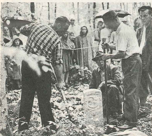
Pose de la borne.
