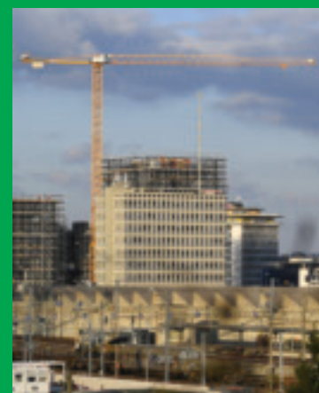
Le chantier du nouveau quartier Pont-Rouge : 122'000m² de commerces, bureaux et activités.
