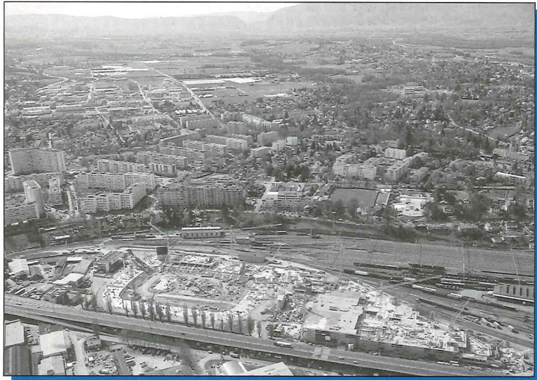
Vue aérienne des chantiers du Stade de Genève, de l'hôtel et du centre commercial à La Praille.
