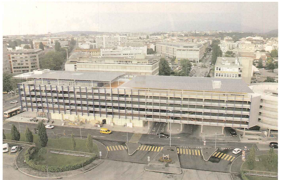
Installation photovoltaïque sur le parking P+R de l'Etoile Auteur: Services Industriels de Genève, SIG, source - SSES Société suisse pour l'énergie solaire
