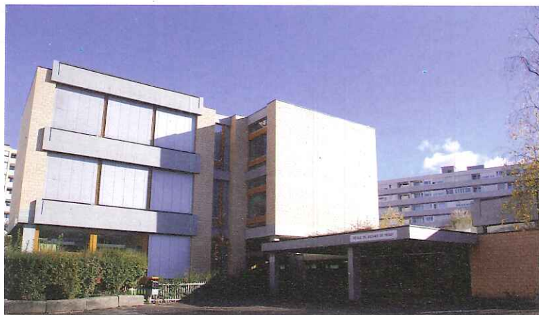
L'exemple de l'école du Bachet entièrement rénovée entre 2005 et 2007
