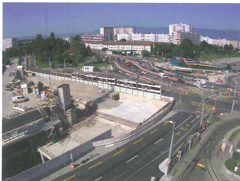
Vue du carrefour du Bachet-de-Pesay: La première phase de construction de l'enceinte située sous la partie de la route de Saint-Julien est terminée et la surface est en cours de remise en état pour une restitution à la circulation dès le 24 août 2013.
