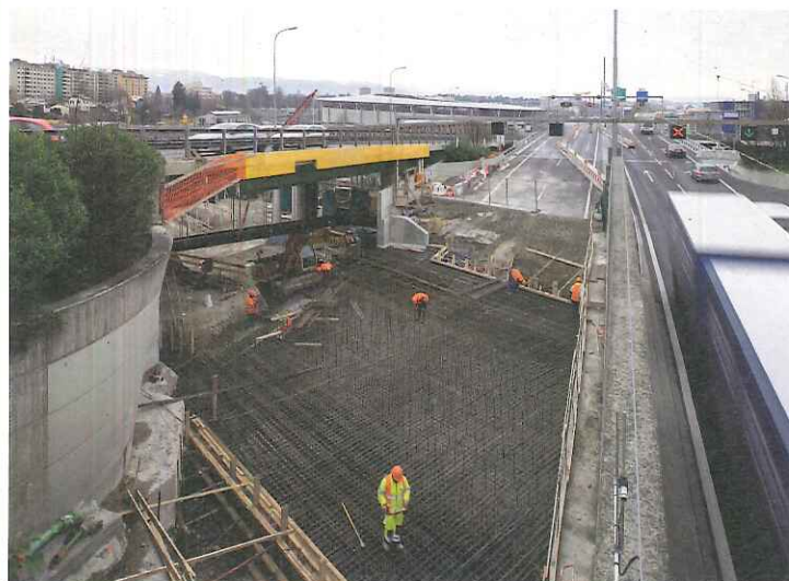
Première phase des travaux sur l'autoroute de contournement
